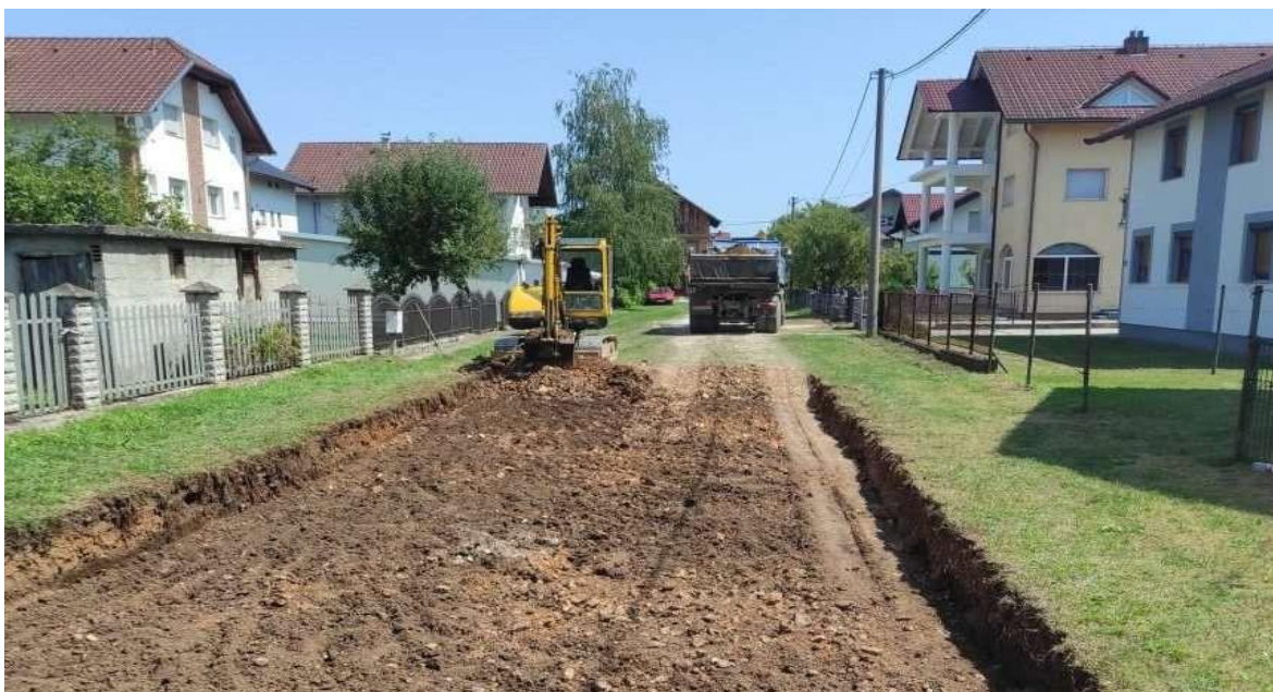
Pripremni radovi za asfaltiranje ulice – MZ Zdena
