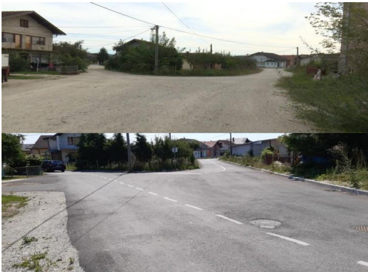
Radovi na izgradnji i rekonstrukciji saobraćajnice u Željezničkom naselju
