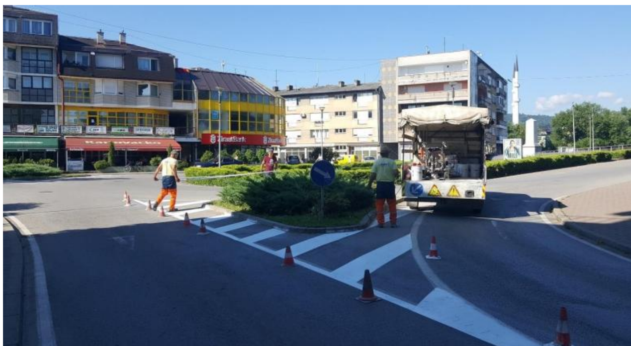
Izvođenje radova na izradi horizontalne signalizacije
